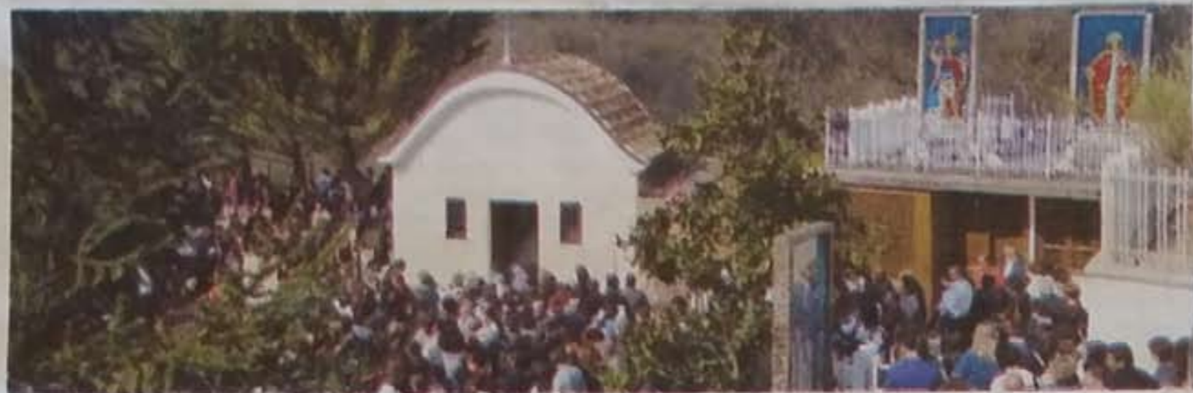
Pellegrini in visita alla Cappella del Bambino Gesù di Gallinaro; sotto il nuovo edificio di culto in costruzione nel centro della Valcomino a ridosso del luogo delle apparizioni
